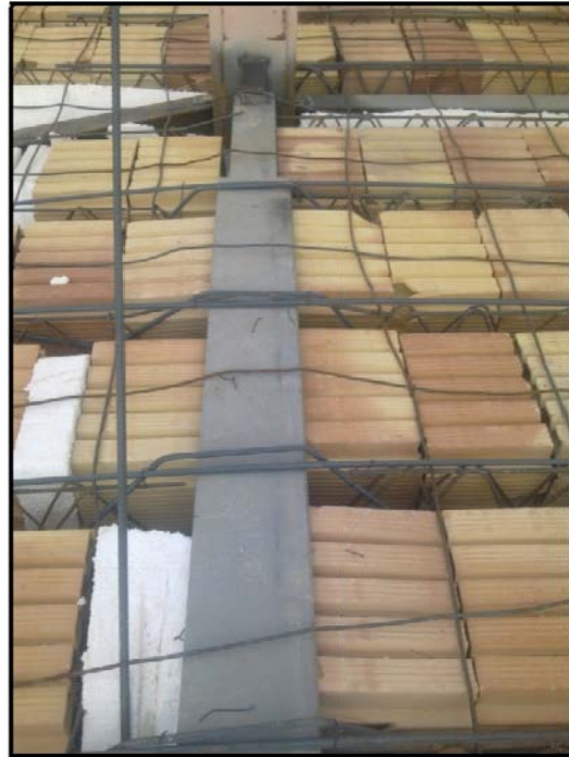
(آرماتور اوتکا دو طرفه در تیر فولادی)
