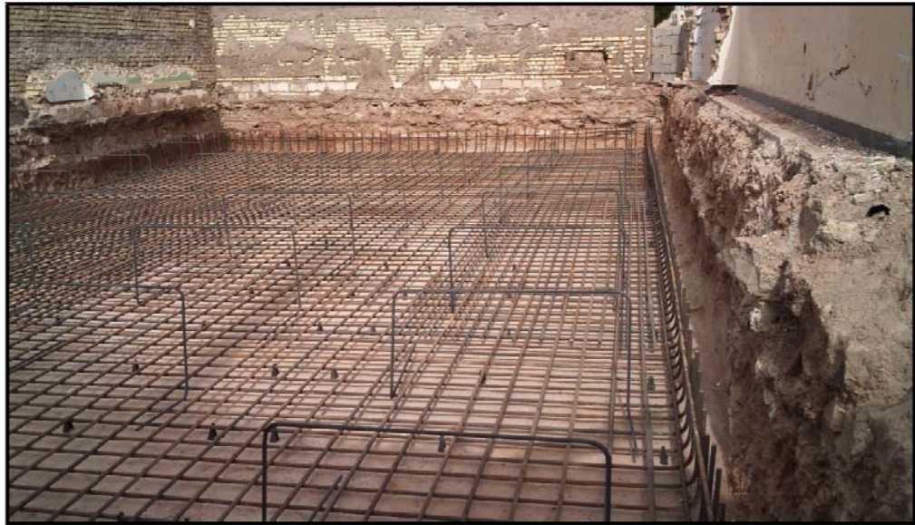
(آرماتورهای خرک در فونداسیون)
