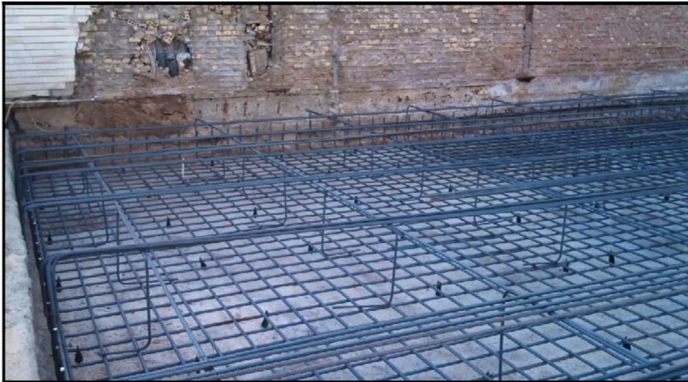
(آرماتورهای خرک در فونداسیون)
