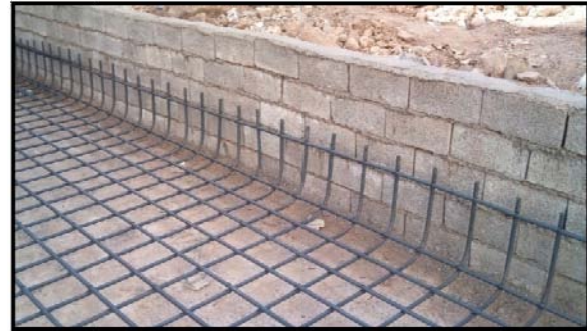
(آرماتورهای تحتانی فونداسیون)
