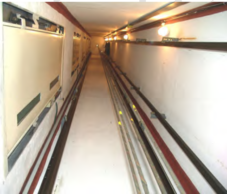
شکل ۱- نمای یک چاه آسانسور.
