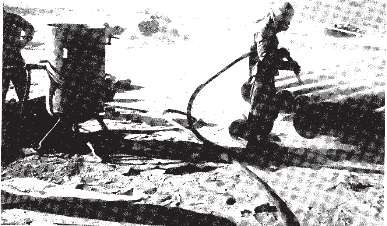
شکل ۹ - ۴۰ - عملیات ماسه پاشی.
